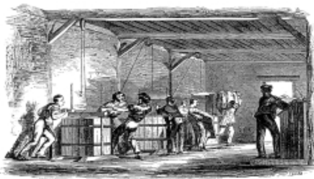
Fig. 8 - ATELIER DES PRESSES POUR LA COMPRESSION ET LA MISE EN BALLES
