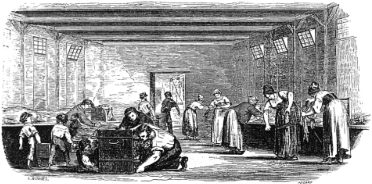
Fig. 6 - ATELIER DE PARAGE DES CHANVRES AU SORTIR DES TEILLEUSES, PESAGE ET EMBLISSAGE DES CAISSES POUR LA COMPRESSION
